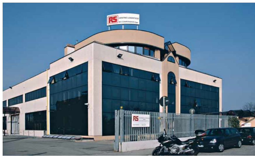
Il Centro Logistico RS Italia di Vimodrone, alle porte di Milano
