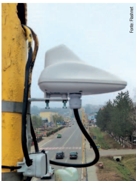
Fig. 4 – Un tradizionale lampione della cittadina di Hîncești, in Moldavia, equipaggiato con il nuovo controllore della lampada LoRaWAN di Flashnet
