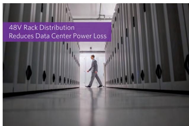
densità e prestazioni in transitorio, grazie all'integrazione tra componenti di potenza e componenti magnetici. La conversione a stadio singolo, da 48V al PoL (da 48V al carico), elimina infatti una componente della perdita di conversione e riduce di un fattore 16 le perdite di potenza dovute alla distribuzione nelle implementazioni rack, rispetto alle architetture a 12V.
